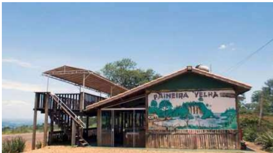
Figura 23 - Vista lateral do Mirante Paineira Velha
