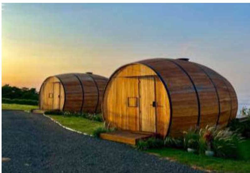
Figura 12 - Unidades de hospedagem do Hotel Villa Dejota
