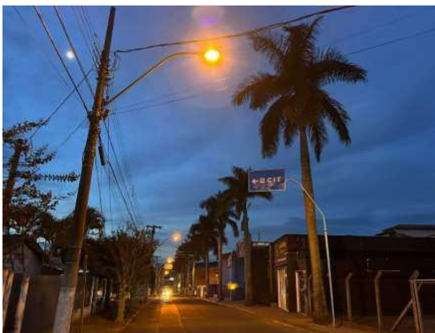
Figura 57 - Postes de iluminação na Rua Euzébio da Rocha Camargo
