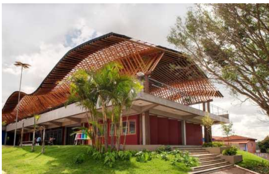
Figura 36 - Vista lateral parcial do CMFCS
