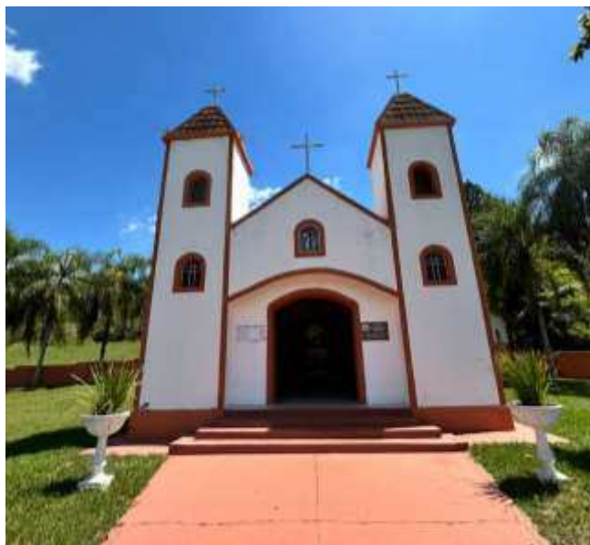
Figura 33 - Vista frontal da Capela de Nossa Senhora Aparecida
