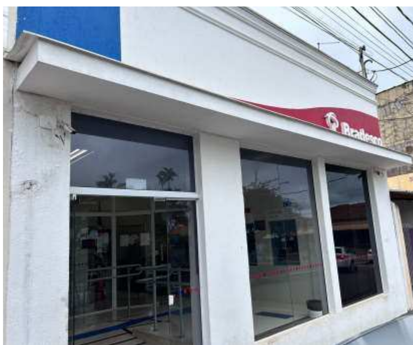
Figura 14 - Fachada do Banco Bradesco – Agência Pardinho
