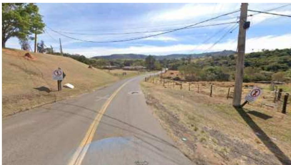
Figura 50 - Trecho inicial da Estrada Municipal João Emílio Roder
