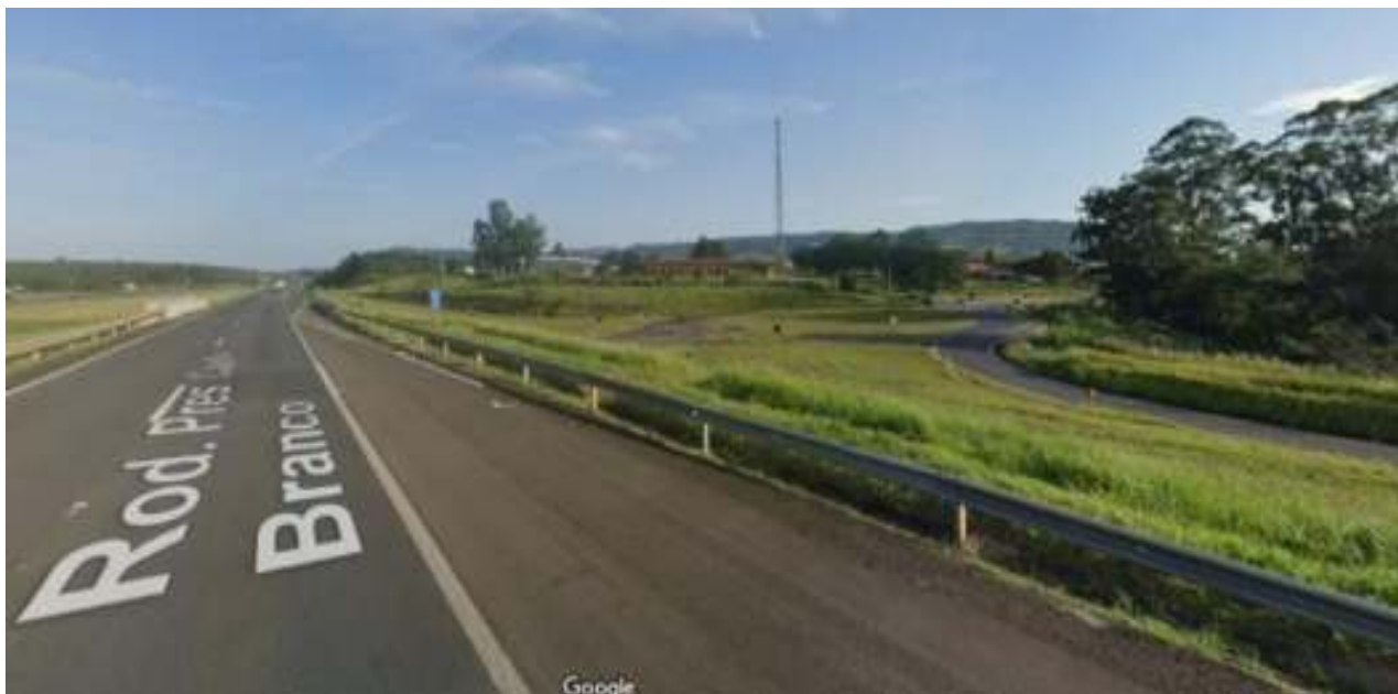
Figura 84 - Acesso do km 183 da SP 280
