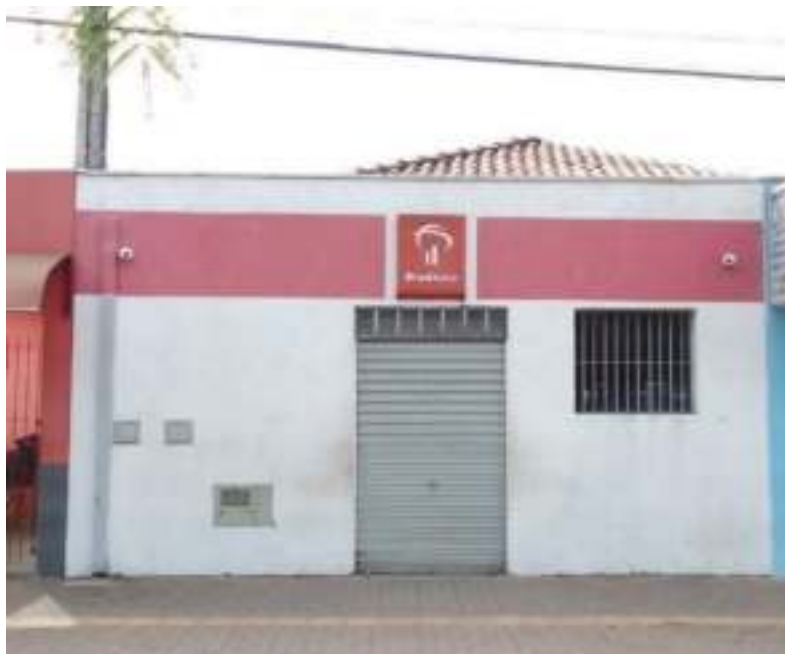
Figura 31 - Fachada do Banco Bradesco Agência Bofete
