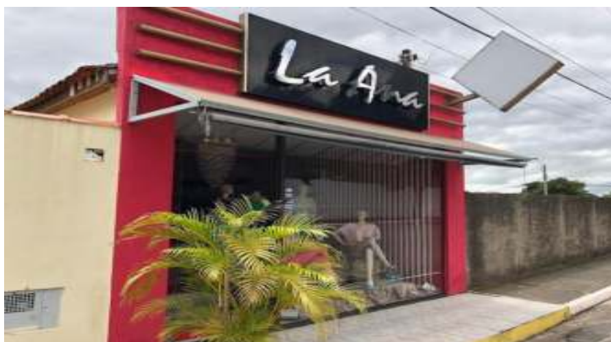
Figura 46 - Fachada da La Ana Modas
