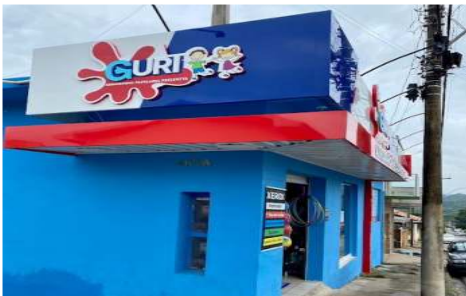
Figura 44 - Fachada do Lojão e Bazar Guri
