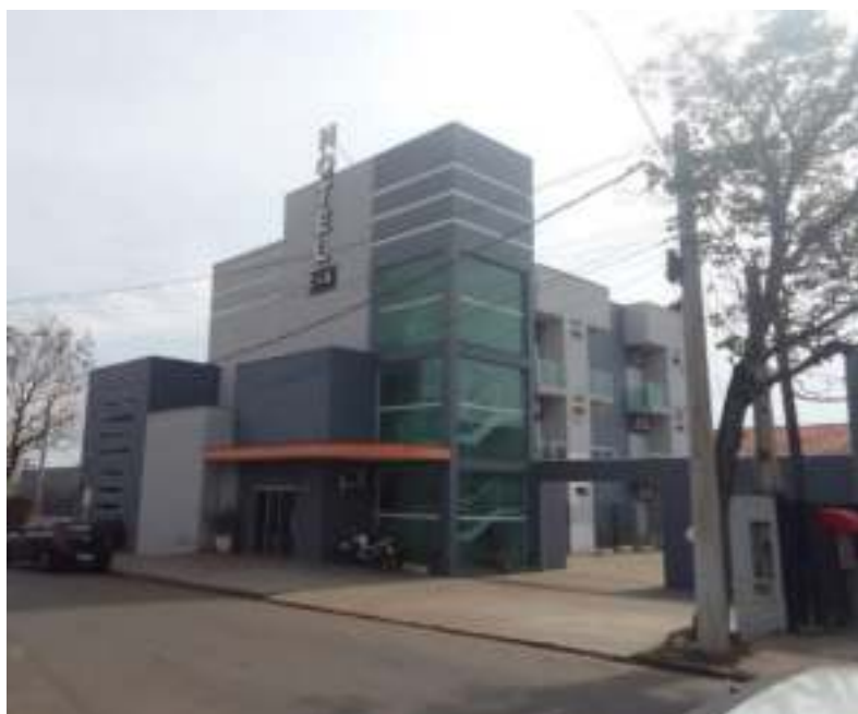
Figura 17 - Fachada e entrada do Hotel C&A
