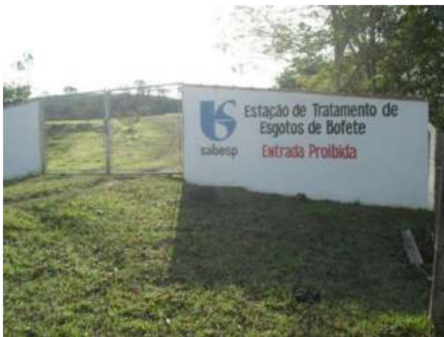
Figura 90 - Estação de tratamento de esgoto da Sabesp em Bofete
